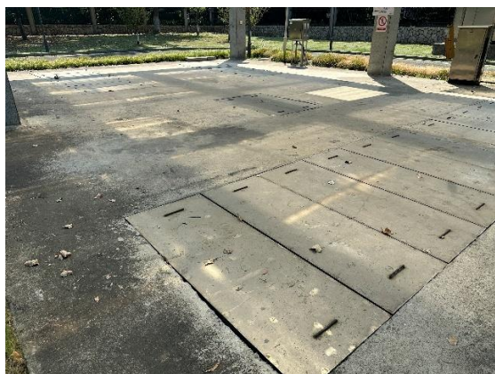
地下泵房地面加盖
