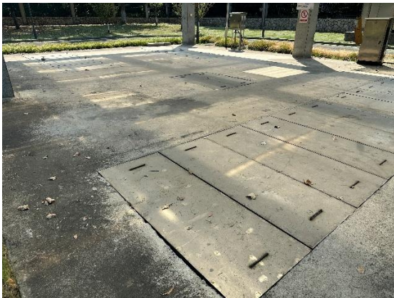
地下泵房地面加盖
